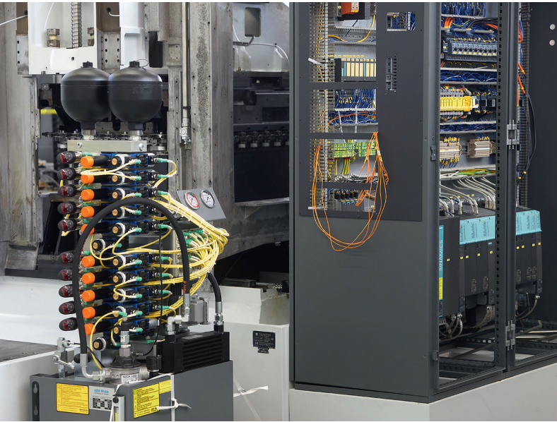
4 Mit die größten Energieverbraucher einer Werkzeugmaschine: Schaltschrank und Hydraulik einer Stama 'MC 531' auf den neuesten Stand gebracht © Chiron Group
